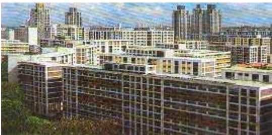
Figure 8: Construction de nouvelles habitations publiques [5]
