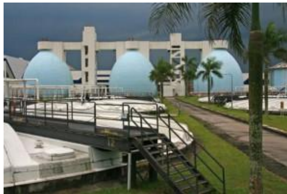
Figure 16: Usine de traitement des eaux usées
