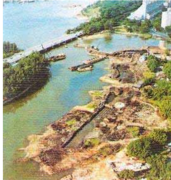
Figure 7: Construction de la digue sur la rivière de Singapour [5]
